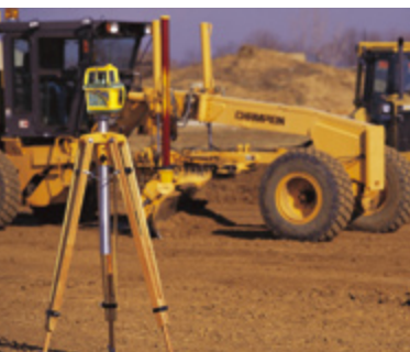
Construcción de carreteras
