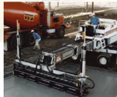
Construcciones de hormigón
